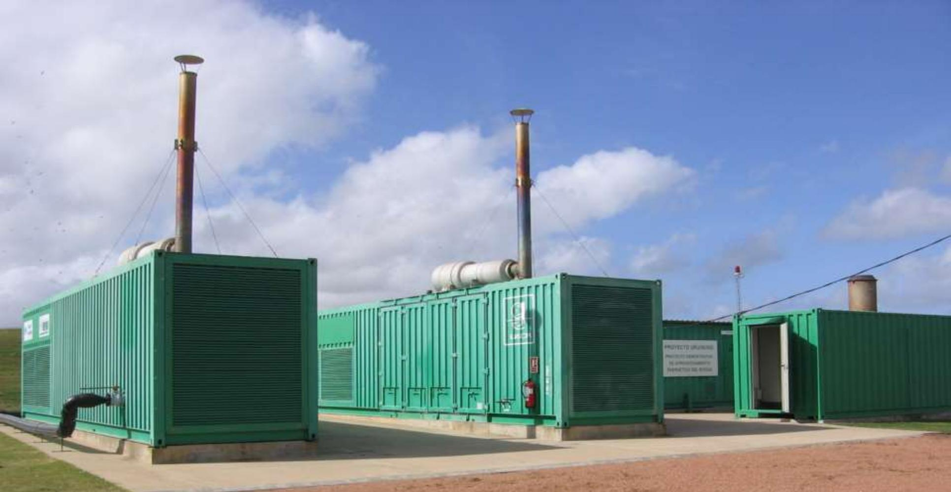
• **2 generadores** eléctricos, **0.5 MW cada uno**, energizados con motores a biogás de 4 tiempos, 12 cilindros y 36 litros.
